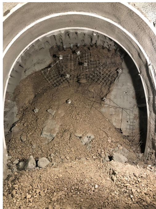
4 Ortsbrustinstabilität beim Vortrieb des Erkundungsstollens (späterer Sicherheitsstollen)
