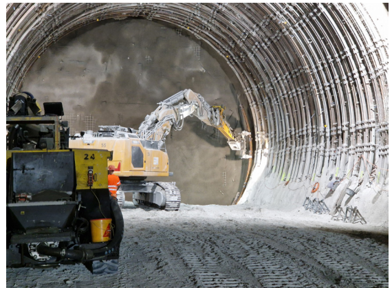
6 Einbau des Seitenelements des TH-Bogens
