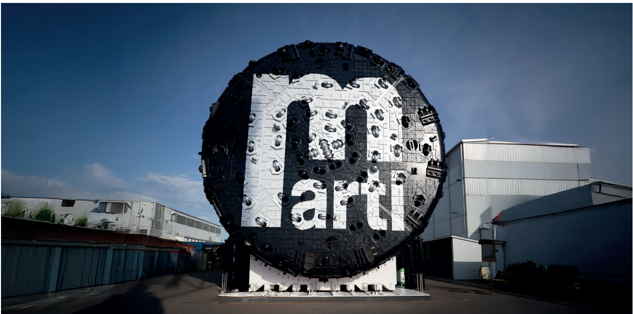
Tunnelbohrmaschine 2. Röhre Gotthard, Los 341
