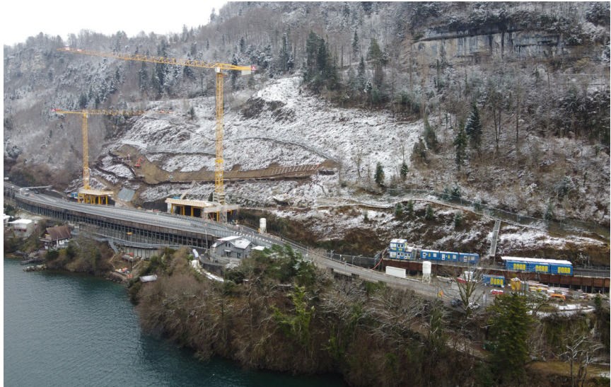
5 Luftbild der bestehenden Axenstrasse mit Verkehrsumleitung über die temporäre Strassenüberführung sowie Installationsfläche auf dem Schutztunnel, beide über das SBB-Gleis, im Bereich Ort, Stand vom Februar 2025
