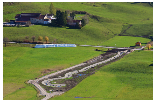
5 Renaturation du Bied et de la Grecque, état 2024
