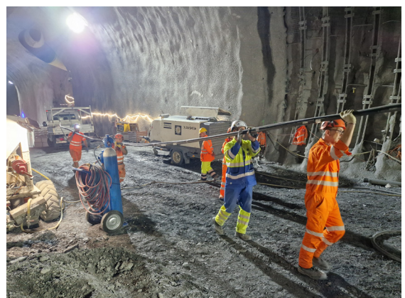
8 Anpacken beim Einbau vom RH-Extensometer
