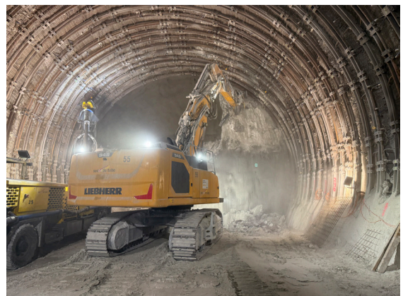
5 Öffnen eines Teilfensters
