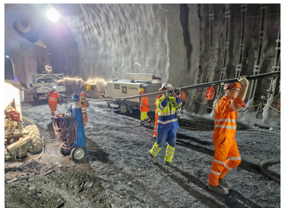
8 Anpacken beim Einbau vom RH-Extensometer
