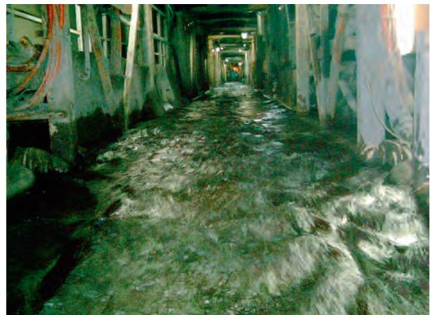
6 Hauptwassereinbruch mit geschätzten 800 l/s im Nachläuferbereich mit Gleisen
