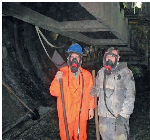
5 Arbeiter mit selbstversorgenden Atmungsgeräten mit Überdruck bei hoher H<sub>2</sub>S-Konzentration in der Tunnelluft, Luftzufuhr über grosse Druckluftflaschen und Schläuche
