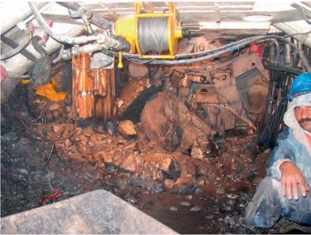
7 Nachgebrochenes Gebirge in der Sohle direkt hinter dem Bohrkopf unter der TBM bei schwierigen Arbeitsbedingungen
