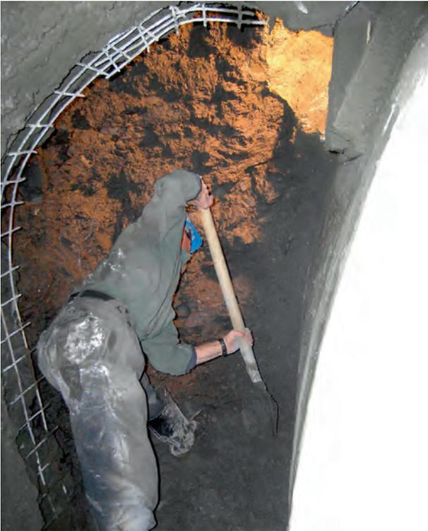
4 Händische Erstellung von seitlichem Bypass (TBM-Schild rechts)
