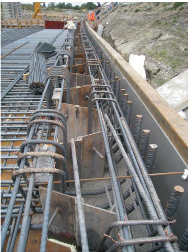
17 Detail Anschluss Spundwand/Tunneldecke
