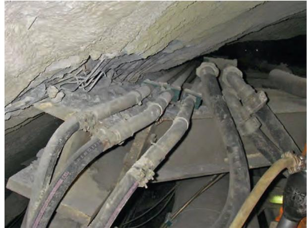
7 *Nachläufer streift an deformierter Ausbruchsicherung*
