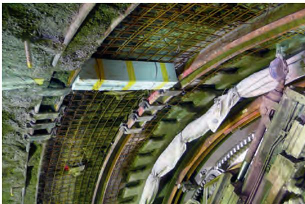
5 Nachgiebige Ausbruchsicherung mit Styrofoam-Element
