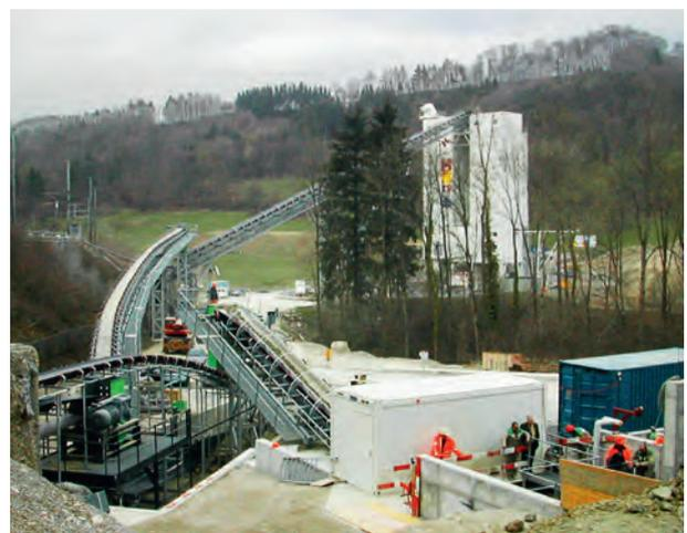
4 Transportband – Stollen Portal Landikon: Aushub-Aufgabestation (rechts) und Kiesbeschickung (links) zu den Betonanlagen im Hintergrund
