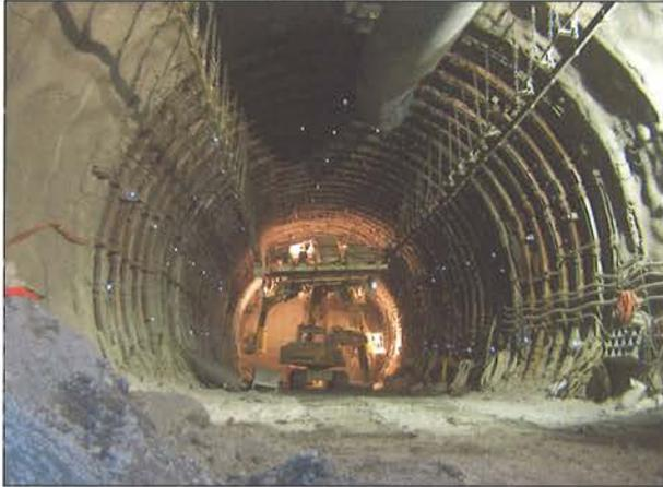
Bild 6: Tunnelbagger mit Adapter für Bogenmontage im Südvortrieb
