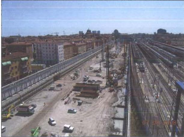
Le strutture sono articolate su più livelli e prevedono il traffico ordinario alla quota dell'attuale stazione (P.F. +42.40 s.l.m.) ed il passaggio di quello AV ad una quota inferiore (P.F. + 19.10 s.l.m.). Una struttura in acciaio interamente
