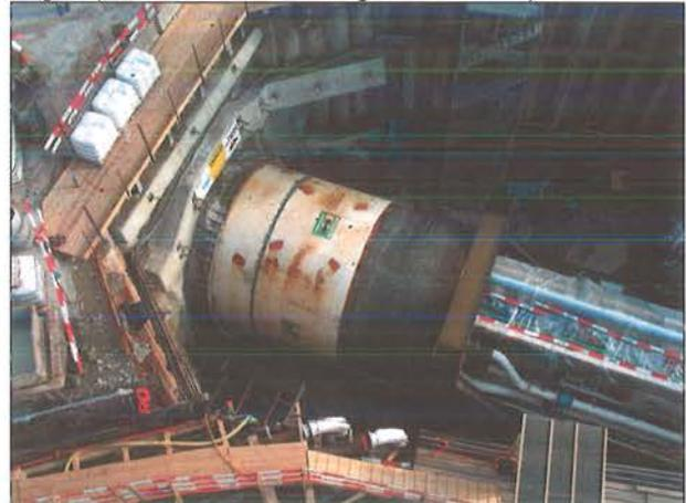
Zwischen dem kreisrunden Tübbing und den Trägern der Rücksteifkonstruktion wird üblicherweise ein Stahl-Druckring montiert, welcher beim Anfahren die Längskräfte überträgt. Der Druckring dient beim Bau des ersten temporären Tübbingrings als Montagehilfe. Die einzelnen Stahlbetonelemente werden an den Stahlring verschraubt und liegen so in der gewünschten Position.
