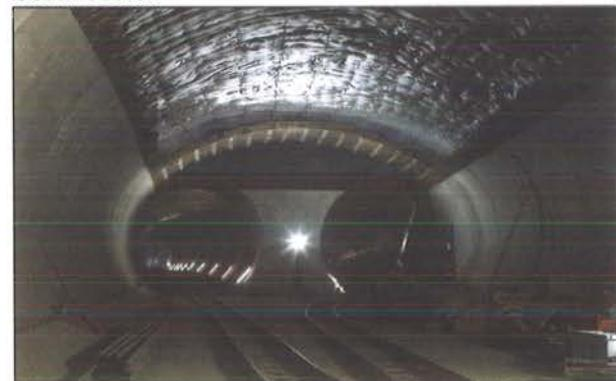
Auch in Sedrun wird Richtung Norden an der Innenverkleidung gearbeitet. Besonders anspruchsvoll sind dabei die imposanten Kavernen der Tunnelwechsellaufweiten. Richtung Süden arbeiten sich Bohrjumbos im Sprengvortrieb Meter für Meter Richtung Faido vor.
