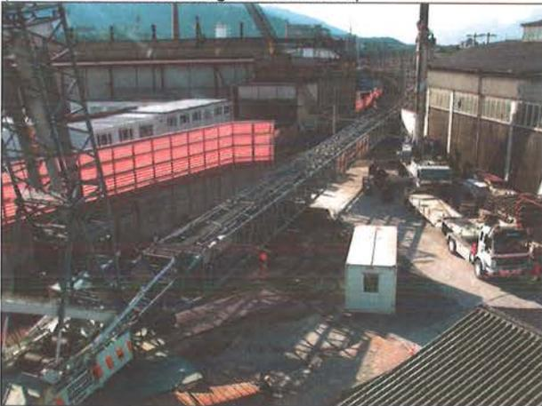
Bild 39: Nachläufer in der Startbaugrube (Hochwasserentlastungsstollen Thun)
