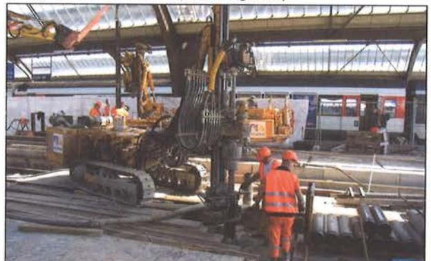
Bild 13: Einbau Gleishilfsbrücken (Quelle ig zalo)
