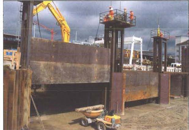
Kommt es zu einer Flutung der Baustelle, werden zuerst alle Spundwandprofile entfernt, dann wird ein Betonelemente nach dem anderen mit dem Seilbagger herausgezogen und auf der provisorischen Dienstbrücke links im Bild gestapelt. Eine Flutung der Baustelle würde immer von der Seite unterstrom erfolgen. Nach dem Entfernen der ersten Elemente läuft die Baugrube kontinuierlich voll. Ist das Füllen abgeschlossen, werden die Fluttore oberstrom gehoben und das Wasser beginnt durchzufließen.
