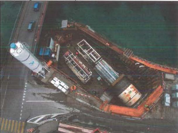
Aufgrund der beschränkten Platzverhältnisse in der Baugrube kann neben dem Schild oft nur ein Teil der Nachläufer montiert werden (Bild 39). So musste in Thun nach dem Anfahren der Nachläufer 3 querverschoben und der Nachläufer 4 nachträglich eingehoben werden.
