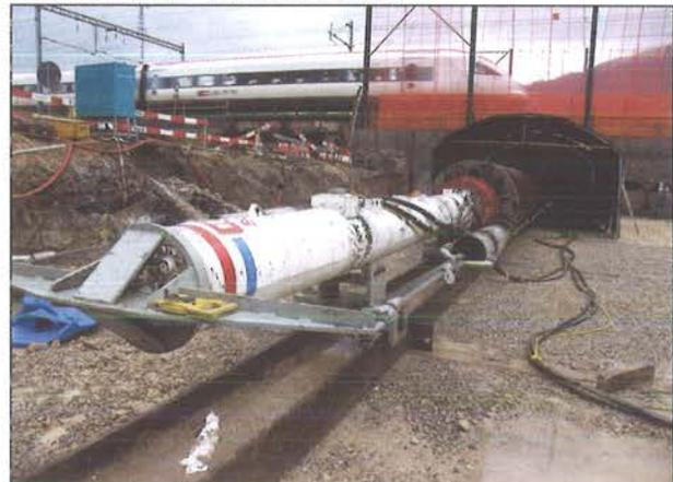
Während im Normalfall für horizontale Einsätze klassische Schlagrammen eingesetzt werden, gelangte für die Arbeiten in Biel eine 7,2 Tonnen schwere Hydoramme zum Einsatz. Die geringere Schlagzahl, verbunden mit einer grösseren Energieeintragung, verminderte die Setzungsanfälligkeit des bindigen Schüttmaterials des Bahndammes.
