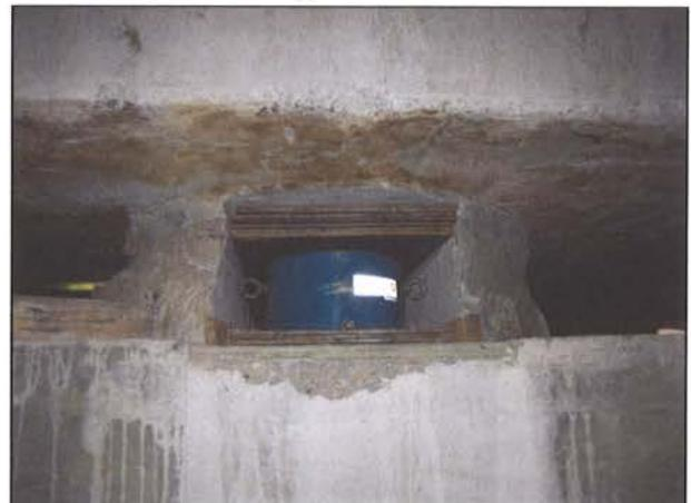
Als zweite Massnahme wurden nach dem Presseneinbau von der zweiten Aushubebene aus rings um den verbleibenden Pfahlabschnitt unterhalb der späteren Aushubsohle Zementinjektionen (Verdichtungsinjektionen) über Manschettenrohre durchgeführt (vgl. Bild 8). Der
