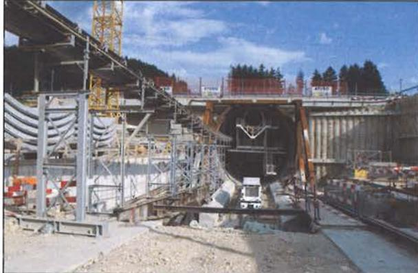
Rasch wechselnde geologische Verhältnisse, wie sie in Biel anzutreffen sind, stellen neben den bekannten hohen Anforderungen eines EPB-Vortriebes an die Konditionierung und Verklebungsthematik des Schneidrades und der Bandanlagen auch zusätzliche Anforderungen an die Steuerung der Vortriebseinrichtungen.
