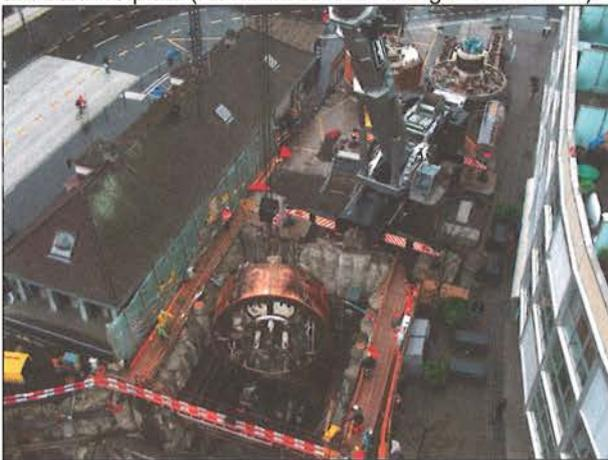
Kann die TBM nicht in den Zielschacht ausgefahren und geborgen werden, besteht die Möglichkeit, den Schild zu entkernen und den verlorenen Schildmantel im Boden zu belassen. Beim Bau des Weinbergtunnels kommt dieses Vorgehen aufgrund der engen Platzverhältnisse am Hauptbahnhof Zürich nach der Ankunft der TBM im
