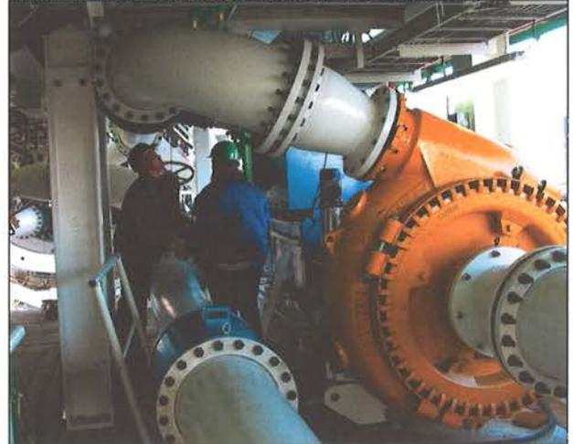
Um die Abrasion und damit den Verschleiss zu begrenzen werden Pumpengehäuse und seitlich angeordnete Schleisswände in Gussausführung vorgesehen. Auslegungsseitig wird die maximale Umfangsgeschwindigkeit der Laufräder von den Pumpenherstellern auf Werte zwischen 30 – 36 m/s begrenzt.
