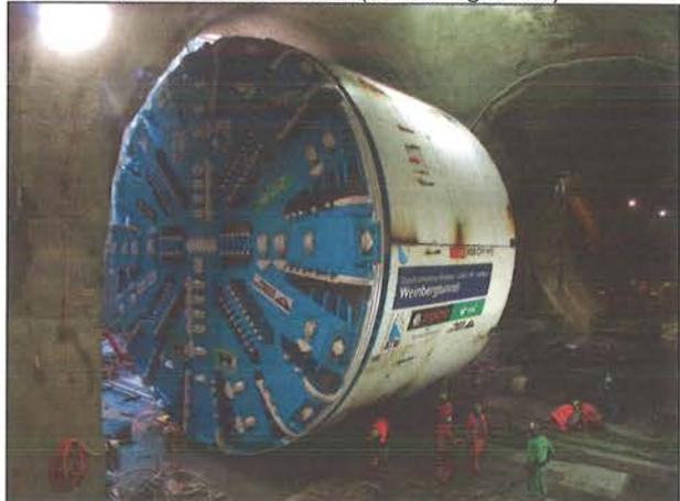
Nebst der mechanischen nimmt insbesondere die hydraulische und elektrische Verbindung von Schild und Nachläufer einige Tage in Anspruch. Vor dem eigentlichen Anfahren ist eine Inbetriebnahme von rund einer Woche einzuplanen.
