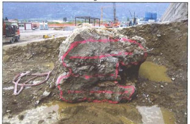
Nach diesen ersten Kontrollen wurden die Jetting-Säulen mit Sorgfalt ausgegraben und freigelegt (Bild 13). An verschiedenen Stellen wurden Schnitte gemacht und Bilder aufgenommen (Bild 14), um das Längsverhalten der Jetting-Säulen zu kontrollieren. An den Säulen wurde bis zu
