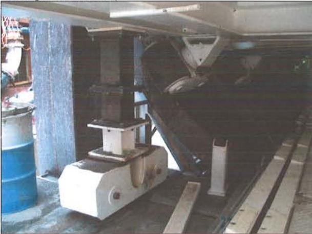
Bild 29: Aufständerung der Nachläuferschienen (Weinbergtunnel)
