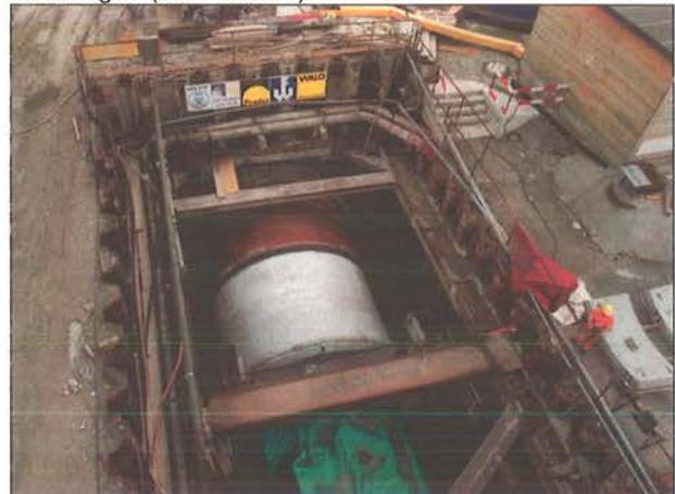
Die Belastungen auf die Rücksteifkonstruktion setzen sich hauptsächlich aus dem Anpressdruck des Schneidrads, dem Stützdruck in der Abbaukammer und der Reibung zwischen Schildmantel und Boden bzw. Schildwiege zusammen. Die Belastungen sind wesentlich niedri-
