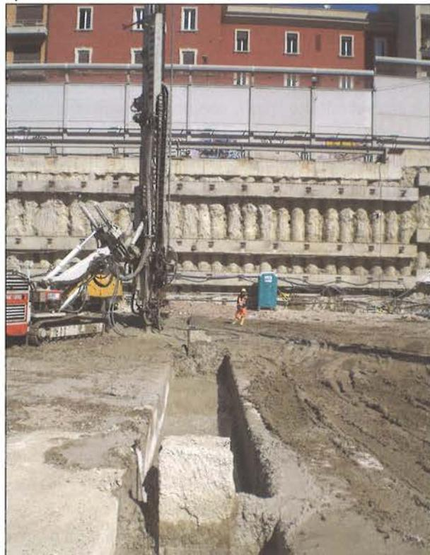
Le fasi esecutive prevedono che il montaggio avvenga prevalentemente con il metodo bottom-up, ad eccezione degli allineamenti 0-4, 19-21, 33-35 e 50-53 in cui le fasi realizzative seguono il metodo top-down.
