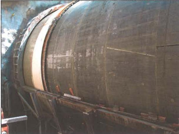
Sobald die Blindringe den Schildschwanz verlassen, müssen diese auf der Schildwiege mit Stahl und Holzkeilen unterstützt werden. Bei Stahlschildwiegen werden die seitlichen in der unteren Ulme liegenden Abstützungen meistens in die Stahlkonstruktion integriert. Die
