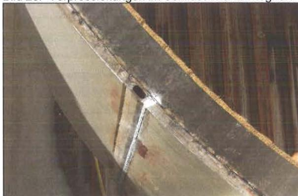
Verpressleitungen im Schildschwanz sollten vorzugsweise in den Stahlbau integriert werden. Aussen angeordnete Verpressleitungen können das Abdichtvermögen der Anfahrdichtungen überfordern und zudem bei Steuerbewegungen mit Kontakt mit lokalen einzelnen Hindernissen ein Eindringen des Schildschwanzes verursachen.
