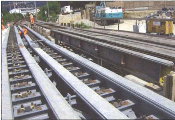
Zur baulichen Unterquerung der in einer Kurve liegenden Gleise der SBB wurden zwei 24 m lange SBB-Hilfsbrücken eingebaut. Damit diese langen Hilfsbrücken überhaupt während der Betriebsphase eingebaut und die dazu in der Mitte sowie seitlichen notwendigen Auflager erstellt werden konnten, erforderte dies im Vorfeld den Einsatz von mehreren kleinen Hilfsbrücken.
