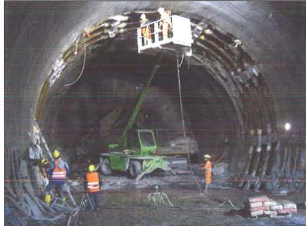
Depuis l'adoption du Profil 2, l'avancement progresse de manière régulière et continue, dans des conditions de sécurité optimales, à la vitesse moyenne de 32 m/mois. Le soutènement multi-phases est bien adapté aux conditions particulières de SMLP et permet de contrôler les convergences à l'arrière de la zone du front. L'expérience acquise est concluante et permet de tirer quelques enseignements:
