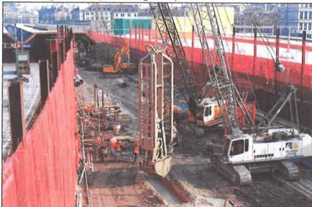
Bild 11: Sihl: Schlitzwandarbeiten mit Spezialgerät unter Bahnbrücken (Quelle ig zalo)
