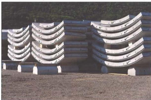
Die Tübbinge werden im externen Fertigteilwerk in Balsthal durch die Firma Marti hergestellt. Eigens für die Anlieferung wurden durch den Unternehmer ein Gleisanschluss gebaut und eine zusätzliche Lagerfläche eingemietet.
