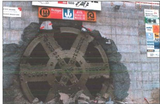
Dieses Prinzip wurde später weiterentwickelt zum drucklosen Werkzeugwechsel, bei dem der geschlossene Arminnenraum zum Werkzeugwechsel unter atmosphärischen Bedingungen gehalten werden kann. Die Speicherschneiräder bewährten sich gut bei der Ortsbruststützung im Vortrieb, hatten aber den Nachteil, dass grosse Ortsbrustbereiche beim Kammereinstieg unter Druckluft frei lagen.
