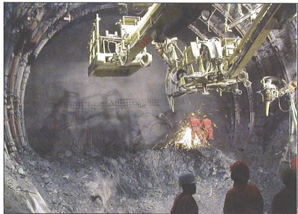
Bild 17: Felssicherung bei Tm 1177, Röhre West
