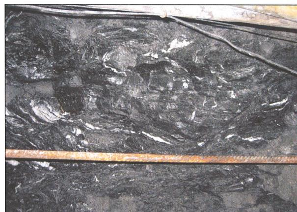
spruchung des Ausbaues führen. Für die verschiedenen Szenarien der Festigkeit der Graphitzone wurden Lösungen untersucht, die von einer intensiven, systematischen Ankerung der Graphitzone, Materialersatz unterschiedlichen Ausmasses bis hin zu einem aufwändigen Ringschluss des Kavernenausbaues im ungünstigsten Fall reichten.
