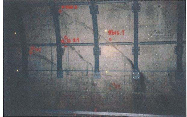
Bis ca. Mitte 2003 wurde die gesamte Tunnelröhre auf einer Länge von 40 m durch den in der Sohle wirkenden Quelldruck annähernd gleichmässig gehoben (ca. 0.5 mm/Jahr). Danach verlief die Hebung der Sohle weiterhin linear und die Firsthebung verlangsamte sich, was als eine Art «Quetschung» der Tunnelröhre interpretiert werden muss. In diesem Abschnitt von 40 m Länge ist denn auch das unbewehrte Innengewölbe durch zahlreiche Diagonal- und Radialrisse beschädigt.
