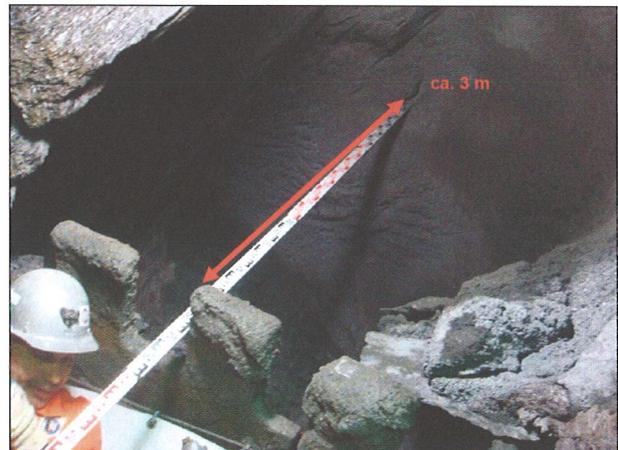
Zum Zeitpunkt der Durchfahrt des nachlaufenden Vortriebes ist die Einspurröhre des vorlaufenden Vortriebes mit Anker, Bögen und Spritzbeton gesichert. Die im nachlaufenden Vortrieb West aufgetretenen Deformationen betrugen in der Firste wiederum bis zu 25 cm, in der Sohle traten Hebungen bis zu 75 cm auf, vermutlich zusätzlich begünstigt durch entsprechende Vorbelastungen und
