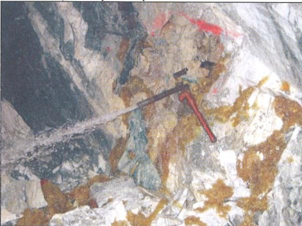
Bild 8: Manschettenrohrinjektion von untertage
