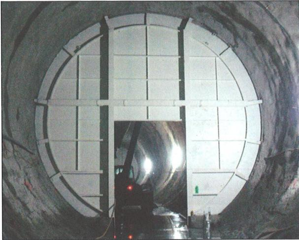
Bild 5b: Wand bei betonierter Sohle
