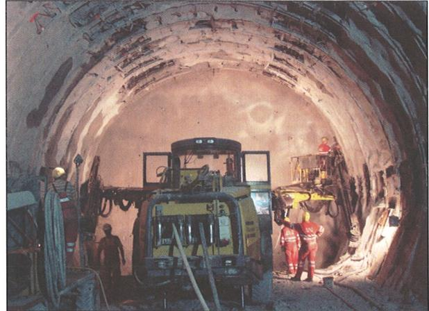
Aufgrund der Vorauserkundung und den Erfahrungen beim Vortrieb des Einspurtunnels Ost wurde in der Weströhre auf eine kontinuierliche Vorauserkundung verzichtet und man beschränkte sich auf die Erkundung der neuralgischen Punkte. So wurde mit der Kernbohrung KB04 die Störung A26 erkundet.
