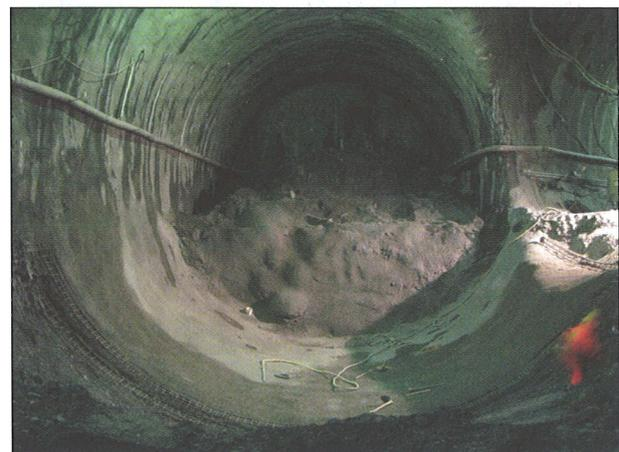
Im Grosshüs werden mit einem Durchlaufbetrieb bei 4 Angriffstellen insgesamt ca. 4 m Vortrieb der Gesamtquerschnitte in beiden Röhren pro AT erreicht. Der Lockergesteinsvortrieb wird bis Ende 2008 abgeschlossen sein.
