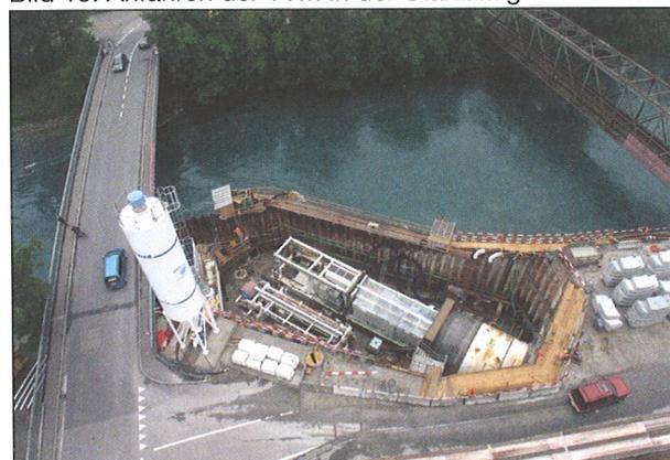
Der Schild wurde auf einer Schildwiege aus Stahl aufgebaut, welche das Anfahren im vorgegebenen Gefälle und in der entsprechenden Richtung ermöglichte. Eine massive, in den Baugrund verankerte Rücksteifkonstruktion ermöglichte das Aufbringen der nötigen Vorschubkräfte beim Anfahren der TVM.
