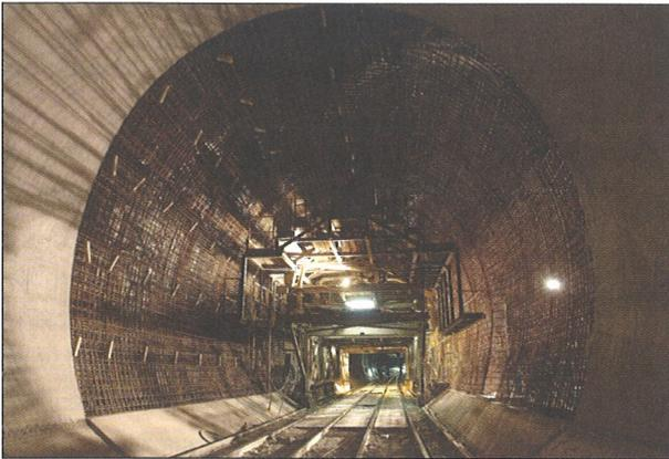
Im Teilabschnitt Bodio kommen die Betonarbeiten für das Innengewölbe gut voran und sind praktisch abgeschlossen. Bis Ende Mai 2008 sind in der Oströhre 98.4% und in der Weströhre 98% des Innengewölbes fertig gestellt worden.
