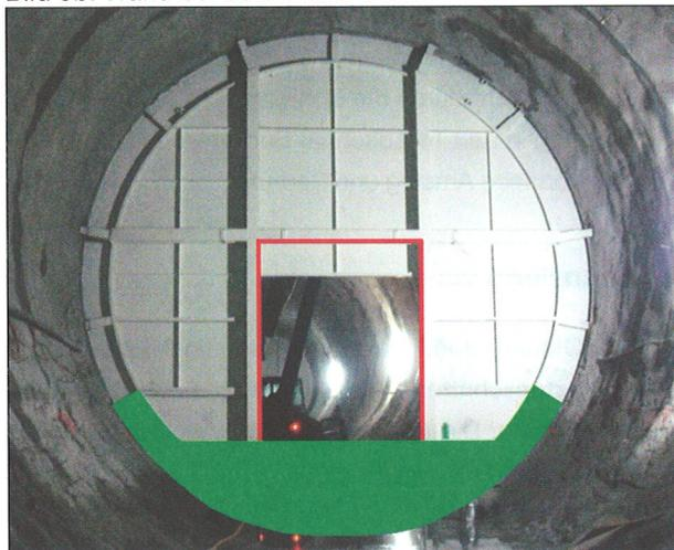
Bild 5c: Wand bei betonierter Sohle und Verkleidung (Innengewölbe)
