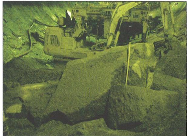
Bild 10: Überprofil oberhalb des TBM-Schildes
