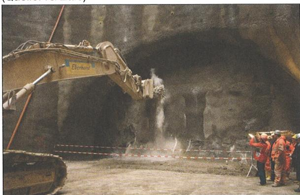
Bild 19: Kalotten-Vortrieb Richtung Oerlikon
