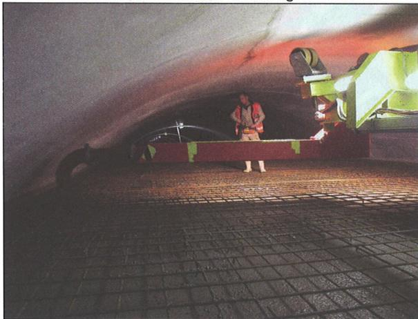
Das Einbringen des Betons erfolgt über eine fest montierte Leitung am Fachwerkträger und ebenfalls über einen drehbaren Arm, so dass die gesamte Breite der Zwischendecke bestrichen werden kann. Pro Tag werden 25 m Zwischendecke betoniert.
