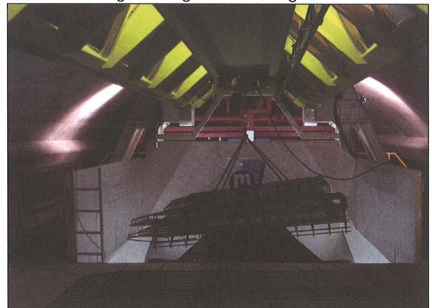
Bild 15: Drehbarer Arm für das Versetzen der Armierungskörbe
