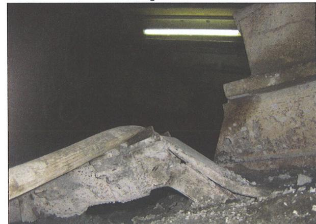
Die Konvergenzen sind nach der Profilierung abgeklungen, so dass der Einbau der Betonsohle möglich wurde. Bis heute sind an der betonierten Tunnelsohle nur einzelne kleine Verformungen aufgetreten.
