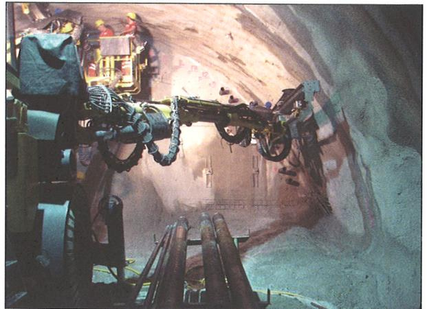
Der weitere Vortrieb erfolgte in der Kalotte im Teilausbruch mit Bagger oder mit Lockerungssprengungen. Dabei wurde jeweils ein Stützkern stehen gelassen. Als Sicherung wurden Stahlbogen HEB 240 im Abstand von 1,00 m mit Spritzbeton und zwei Lagen Netzen K188 eingebaut. Mittels 5-Punkt Konvergenzmessungen wurden die Deformationen überwacht. Der zweite Rohrschirm wies eine Länge von 18 m auf und reichte bis über den Bohrkopf. Die Sicherung erfolgte analog dem ersten Rohrschirm.
