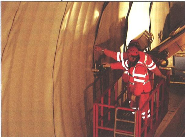
Bild 12: Installationswagen für Zwischendecke
