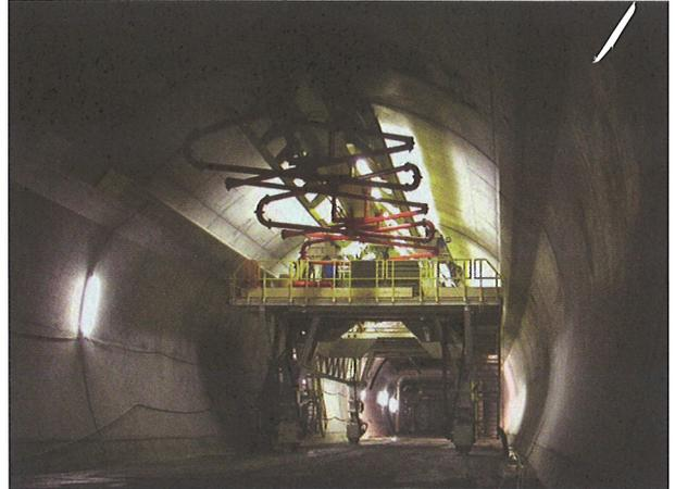
Bild 13: Ausfahrbarer Fachwerkträger
