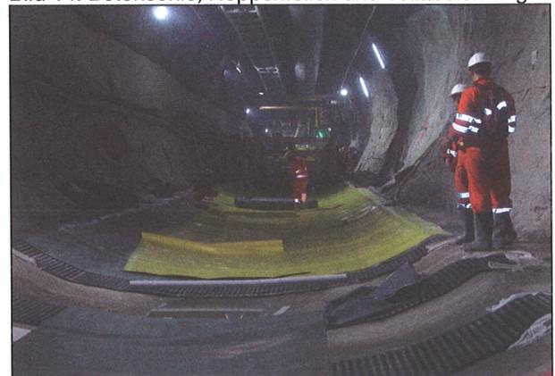
In den Bereichen mit Regenschirmabdichtung wird in der Sohle ein längslaufender Noppenbahnstreifen von 2 m Breite verlegt. Quernoppenbahnen erlauben das Hochsteigen von Wasser in die seitlich ausserhalb der Sohle angeordnete Gewölbdrainageleitung.
