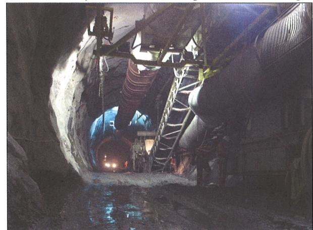
Für das Aufbringen des Spritzbetons steht pro Vortrieb ein Spritzmobil zur Verfügung. Der Beton wird im Vortriebsbereich ab Ende Sohlbetonbaustelle mit 2 Fahrmischern transportiert.
