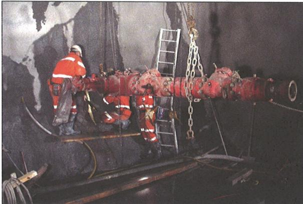
Die Vorauserkundung des Gebirges erfolgt im GM primär mit systematischen, zwischen 40 und 70 m langen Schlagbohrungen. Die vorausseilende Röhre wird grundsätzlich doppelt erbohrt, die minimale Überlappungslänge beträgt dabei 20 m. In der nachfolgenden Röhre beträgt die Überlappungslänge min. 10 m.
