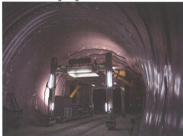
Mit dem ersten Arm werden die 2 m breiten Dichtungsbahnen verlegt. Mit dem Abrollen der Folie werden auf der Vorderseite die Tübbinge für die nächste Dichtungsbahn vorbereitet. Mit 4 Bürsten werden die Verklebungsflächen gereinigt und falls notwendig mit Wärmelampen getrocknet.
