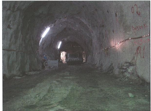
Die Schutterung erfolgt mit 2 Fahrladern, die das Ausbruchmaterial in die sich ca. 30–50 m hinter der Ortsbrust befindlichen Vorbrecher transportieren. Im Schlagwalzenbrecher wird das Ausbruchmaterial auf die Grösse 0/200 zerkleinert.
