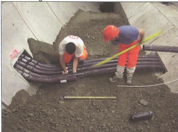
Für die Ableitungen aus den Siphonschächten werden vor die Aussparungen im Werkleitungskanal auf der Aussenseite vorgefertigte Betonelemente, wie Lichtschächte, versetzt und mit Deckel verschlossen. Nach der Montage der Siphonschächte und Ableitungen werden die Elemente ausbetoniert. Auf die gleiche Art werden für die Spülleitungen Elemente bis zu den Tübbinggen versetzt.
