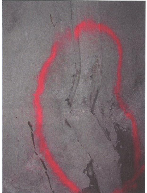
Bild 20: Spritzbetonabplatzungen
