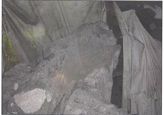
Bild 11: Niederbruch, loses Material auf Sohle
