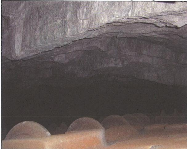
Im Nachläufer-Bereich bewirken diese Bergschläge eine teilweise Zerstörung der schon eingebauten Sicherungsmittel.
