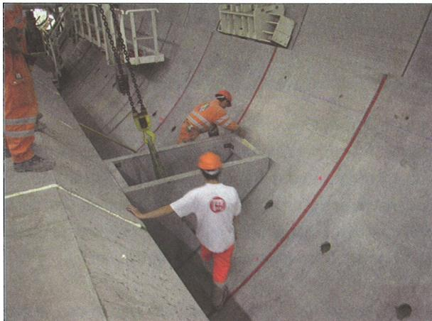
Beim Vortrieb der ersten Tunnelröhre wurden alle 300 m über diesen vorgefertigten Elementen Rettungscontainer aufgestellt. Über eine Öffnung im Containerboden konnten diese Elemente als Fluchtweg aus dem Fahrraum in den Werkleitungskanal benutzt werden. Der Werkleitungskanal verfügt über eine von der Tunnelventilation unabhängige Lüftung.
