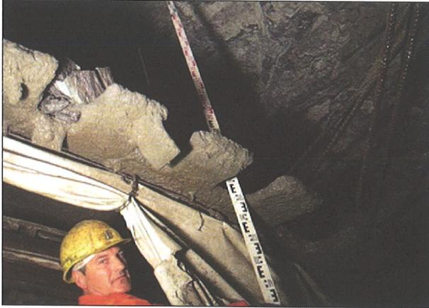
Bild 9: Niederbruch über dem Fingerschild
