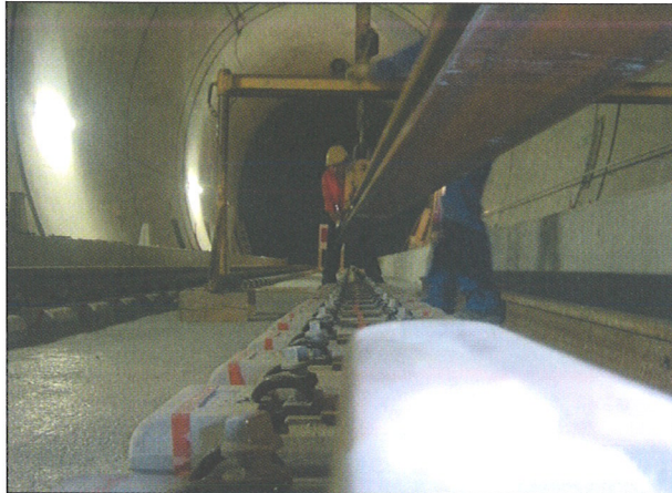
Bild 13: Verlegen der Schienen
