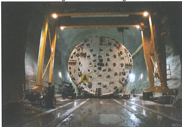
Bild 7: TBM Montage Oströhre Amsteg
