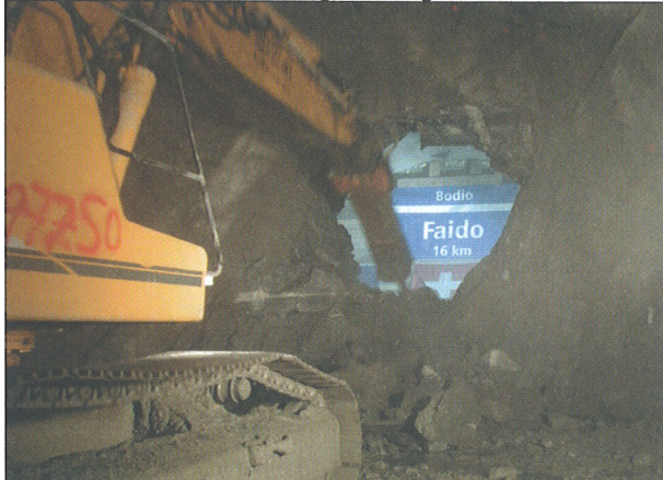
Bild 11: Bodio: Durchschlag Lockergesteinsstrecke
