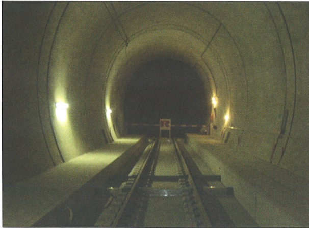
Bild 18: Feste Fahrbahn in der Versuchsstrecke
