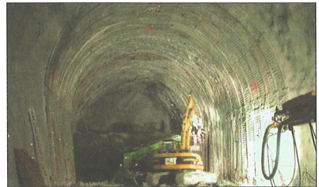
Bild 7: Sicherung Kreuzgewölbe
