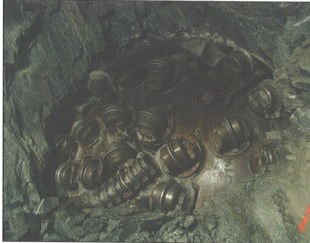
Bild 4: TBM-Kabelstollen, Durchschlag 17. Januar 2003
