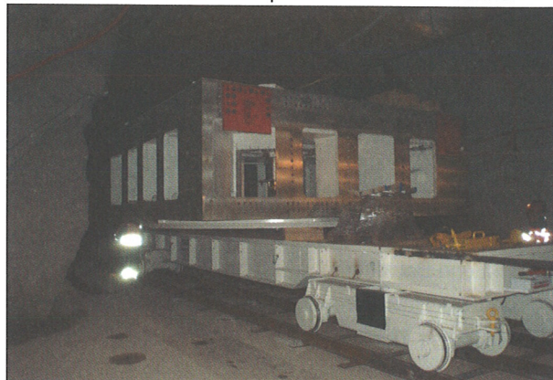
Bild 5: Einfahrt des Bohrkopfzentrums in den Tunnel
