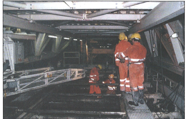
Bild 11: Einbau Sohlenbeton
