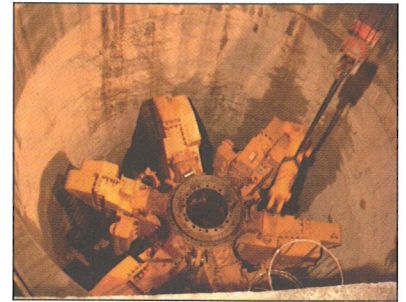
Bild 12: Montage Vortriebsmaschine
