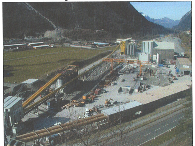
Bild 8: Aussenanlagen: Technische Installationen
