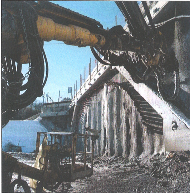
Bild 3: Unterquerung der Bahnstrecke beim Nordportal
