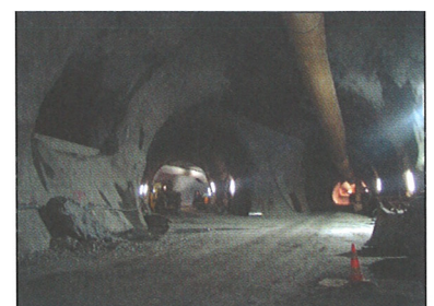
Bild 3: Kreuzungsbauwerk mit Bandstollen, Baustollen und Weströhre (v.l.n.r.)
