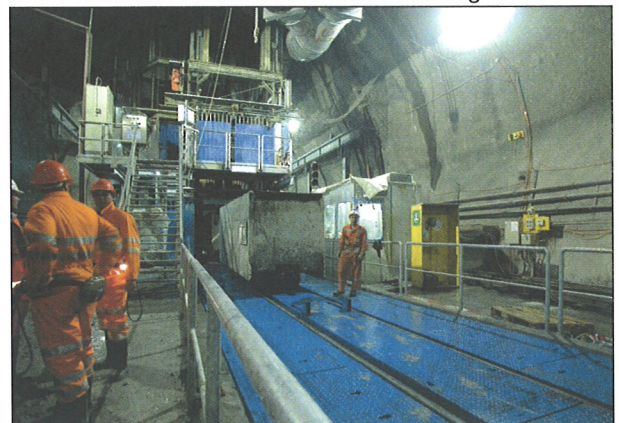
Bild 9: Sedrun: Schachtfuss mit Förderanlage
