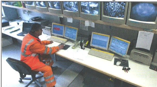
Bild 6: Maschinistenraum der Betonanlage in Bodio
