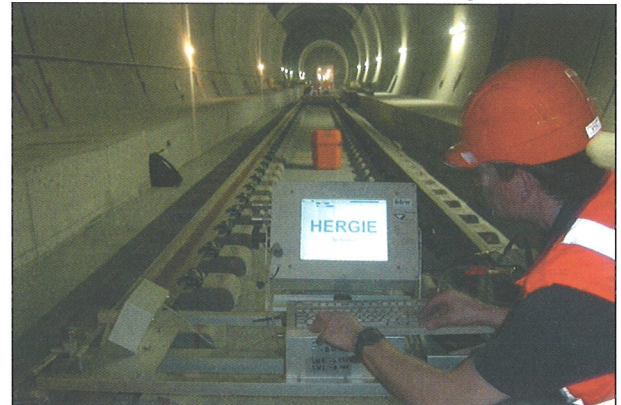
Bild 14: Feinrichten und Prüfen der Gleislage
