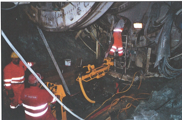
Bild 15: Kernbohrung in der Oströhre
