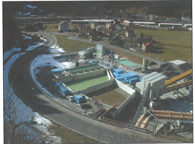
Bild 7: Wasserbehandlungsanlage, umgelegte Kantonsstrasse und Portal Zugangsstollen
