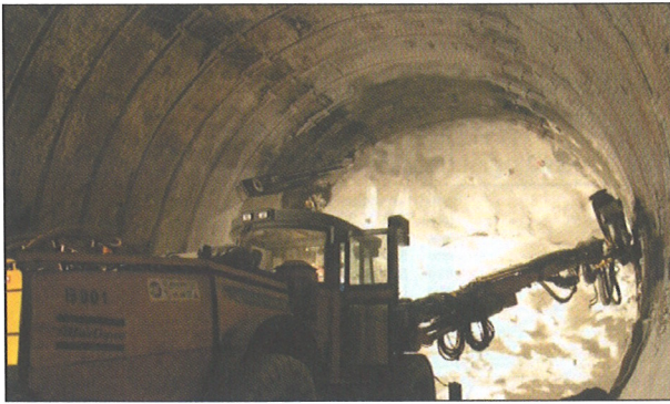
Bild 9: Stahleinbau Einspurtunnel Ost Süd
