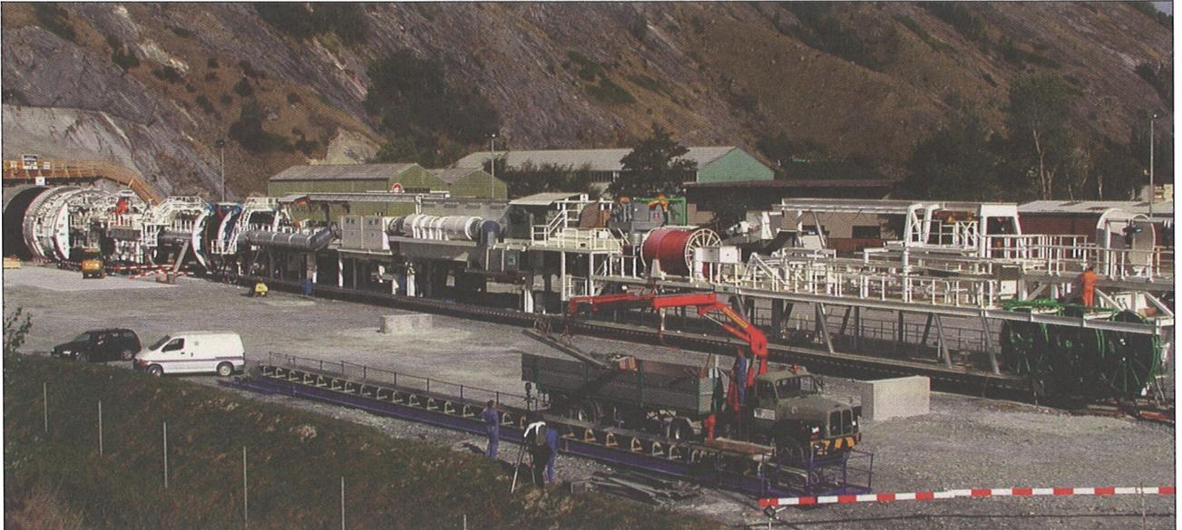
Netz und Spritzbeton, und in der Sohle die vorgefertigten Tübbinge versetzt. Nach Beendigung des Vortriebes erfolgt in einem separaten Arbeitsgang der Einbau des Innengewölbes, der Bankette mit den Werkleitungen und der Fahrbahnplatte.
