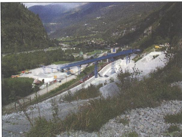
Ein Teil des überschüssigen Ausbruchmaterials des Tunnelabschnittes Faido wird über ein rund 5 km langes Förderband in einen stillgelegten Steinbruch (Caviencia) transportiert. Mit diesem Ausbruchmaterial kann eine weitgehende Rekultivierung jener Zone erreicht werden.
