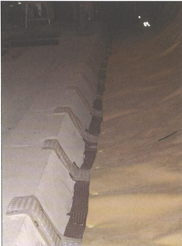
Bild 14: Sohl-tübbing mit eingebauten Drainageleitungen
