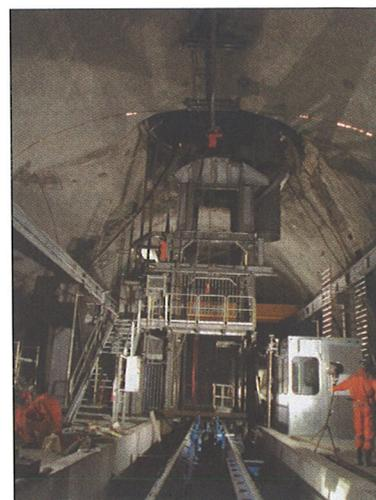
und Logistikzentrum. Zurzeit wird eine neue leistungsstarke Schachtförderanlage eingebaut, die täglich 6000 Tonnen Ausbruchmaterial aus dem Vortrieb vom Schachtfuss zum Schachtkopf transportiert. Pro Fahrt werden ca. 40 Tonnen Ausbruchmaterial in rund 1 Minute durch den 800 Meter hohen Schacht befördert.
