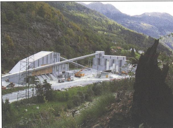
Seit Frühjahr 2001 ist in Faido auch die sehr eindrückliche Anlage für die Materialaufbereitung in Betrieb. Mit dieser Anlage wird auch hier geeignetes Ausbruchmaterial vor Ort zu Betonzuschlagstoffen aufbereitet und wieder verwertet.
