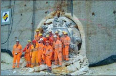
Le tunnel du Neu-Bois, sur les communes de Boncourt et Buix, est constitué de deux tubes parallèles de 941 mètres chacun. La longueur à réaliser en souterrain est de 765 mètres pour chaque tube. Cette partie souterraine est prolongée par des tranchées couvertes de 118 et 86 mètres au Nord et de 90 et 58 mètres au Sud.
