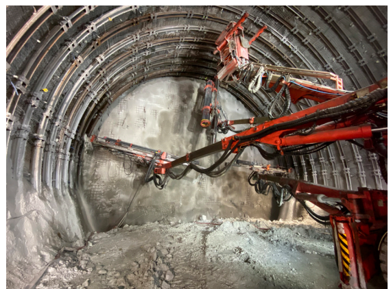
7 Bohren der Radialanker
